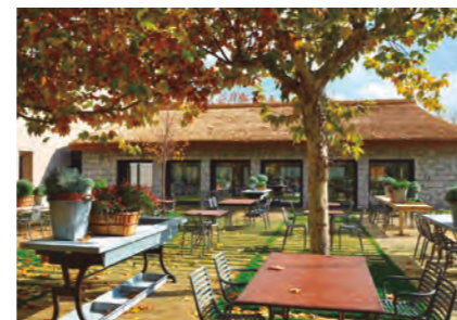
RESTAURANTE FILANDON - Madrid 1 sistema bomba de calor AIRSTAGE V-II (Potencia instalada 90 kW)
